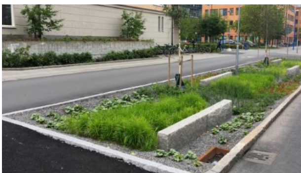
Bild 4.4 och 4.5 Exempel på regnbädd och principuppbyggnad för rening och fördröjning.
