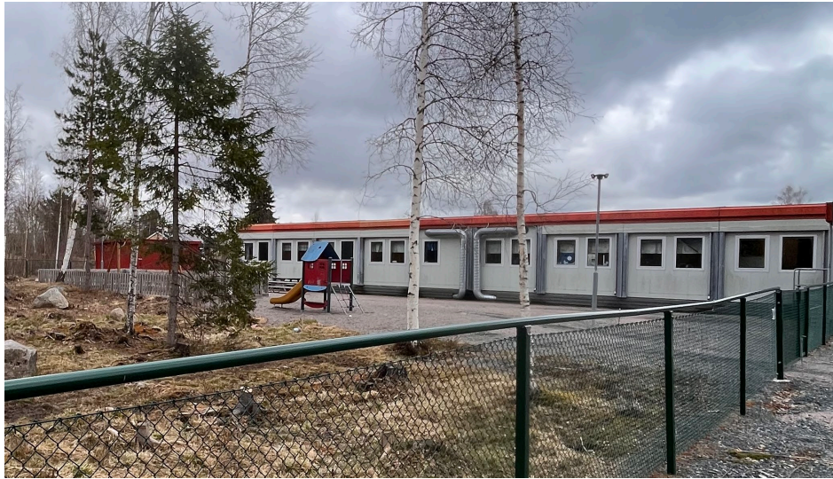
Förskolebyggnaden, sett norrifrån.
