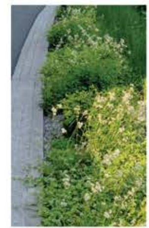
Dagvattenhantering Foto Tyréns
