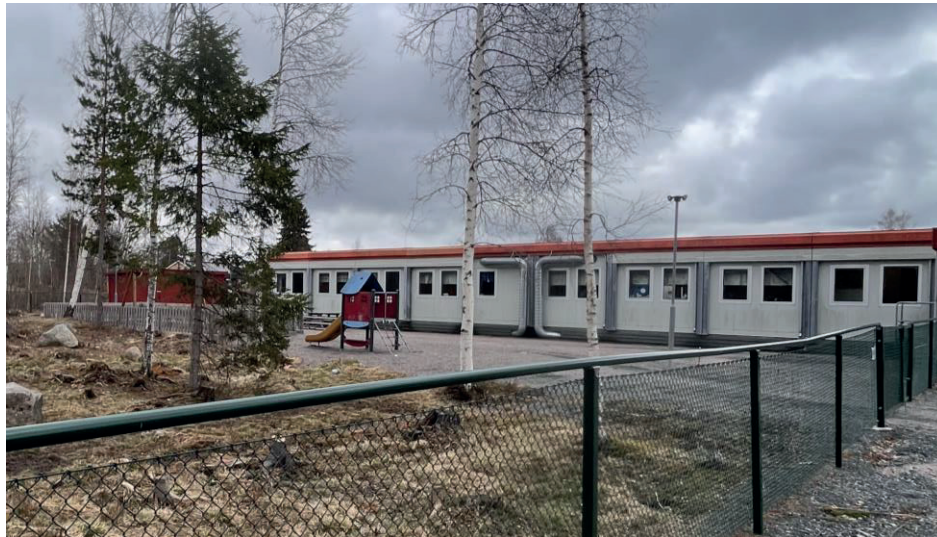
Förskolebyggnaden, sett norrifrån.
