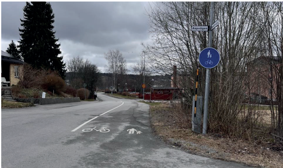
Gång- och cykelväg längs med Bergstäktsvägen ansluter till förskolan i öst. På denna yta angör även bilar olovligt.
