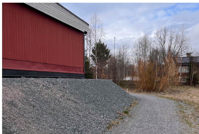
Låg uppsikt i sambandet mellan norra och södra gårdarna.
