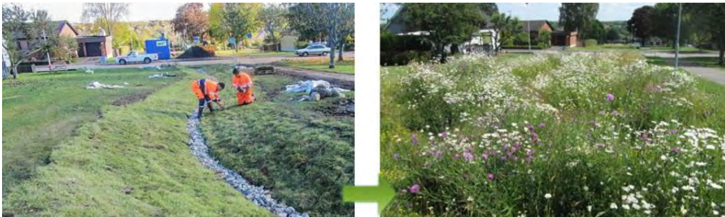
Figur 9. Exempel på hur ett större svackdike kan utformas. Figuren är hämtad från VegTech.
