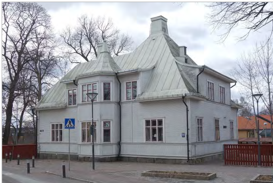
Huset längs Västra Långgatan uppfördes vid sekelskiftet 1900 och var ursprungligen en egen bostadsfastighet inom kvarteret Jumbo. Det införlivades i skolområdet vid upprättandet av detaljplanen 1989. Huset är välbevarat och uppfyller kriterierna för särskilt värdefull byggnad enligt PBL.
