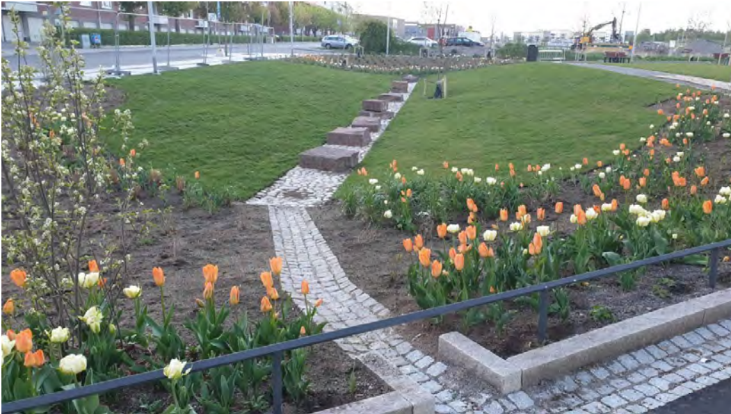
Figur 18. Torrdamm i bostadsområde.
