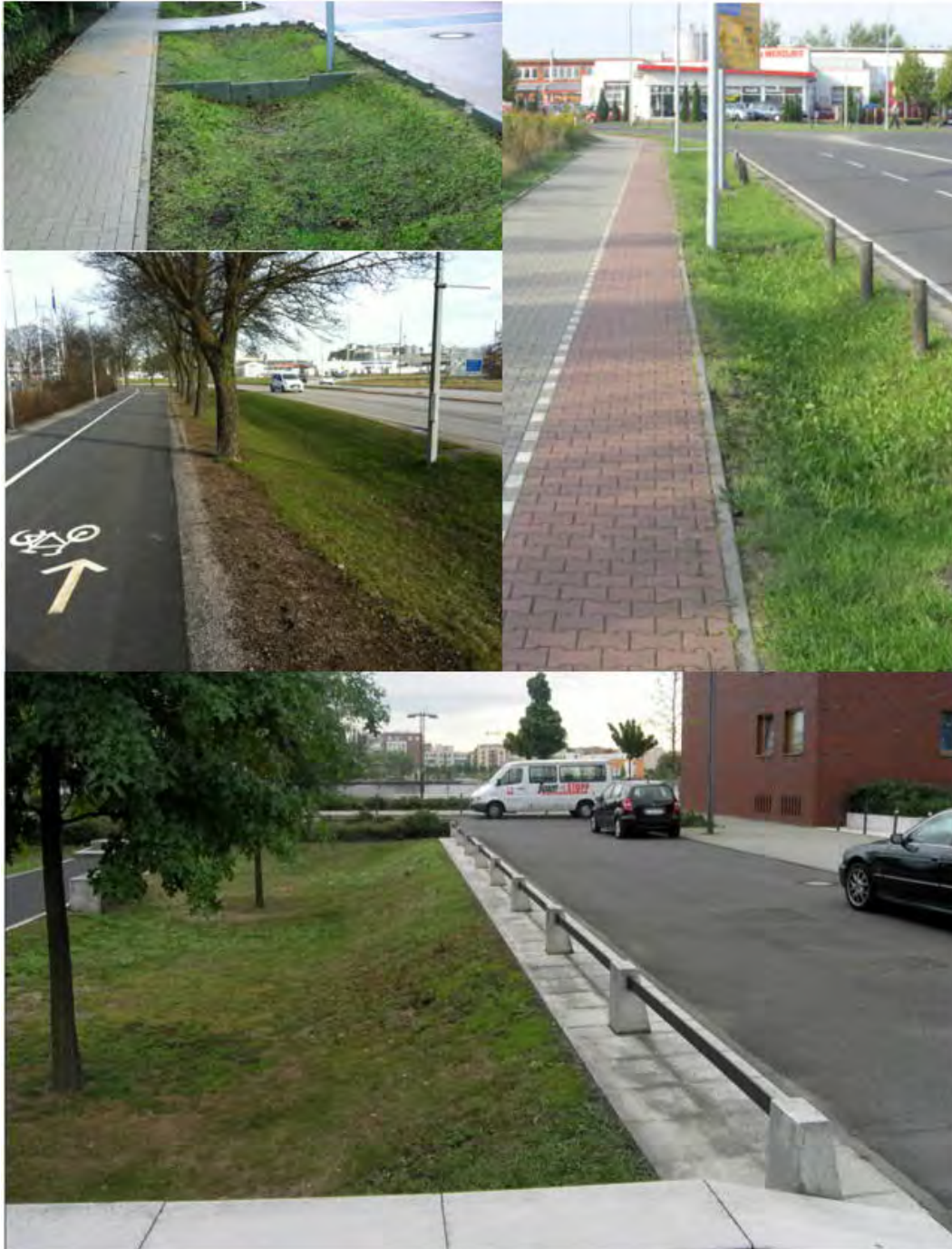
Figur 16. Exempelbilder för Svackdike (Foto: WMS).
