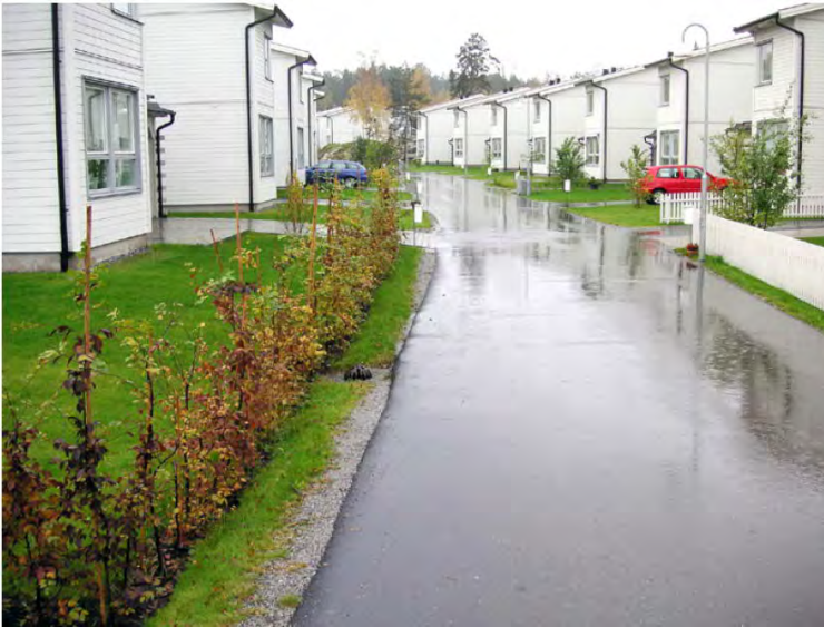
Figur 17. Exempel på makadamdike inom bostadskvarter (Foto: WRS).
