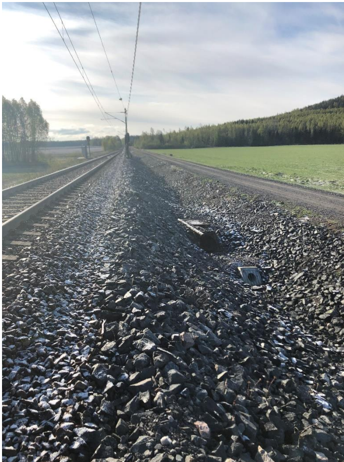
Figur 8. Brunn söder om befintligt spår vid cirka km 49+480 som korsande trumma under järnvägen ansluter till. Vy: östlig riktning.
