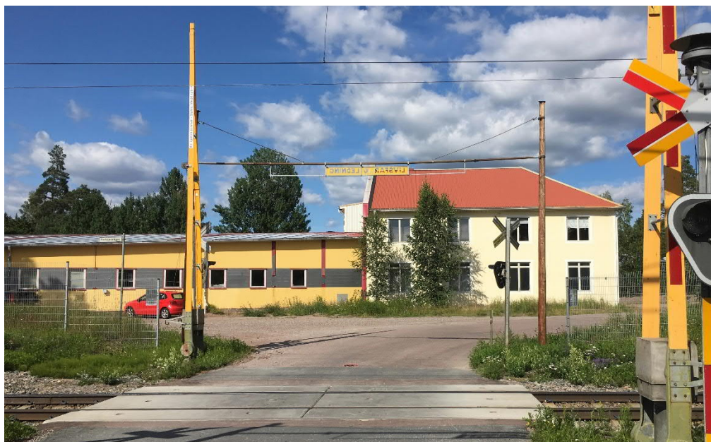
Industribyggnaden vid järnvägsövergången
