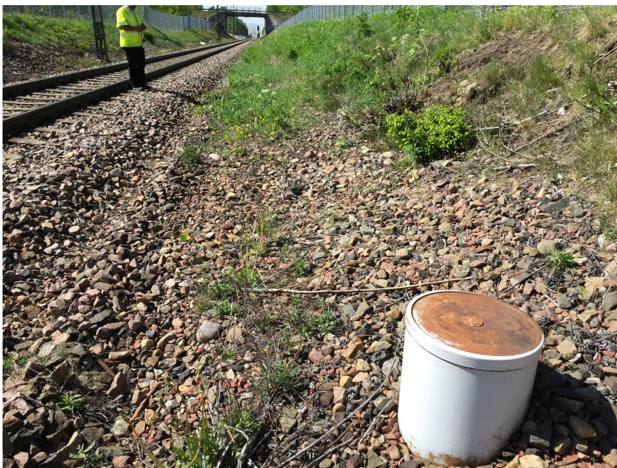
Figur 7. Befintliga rensbrunnar för avvattningssystemet. Vy: västerut i förhållande till befintlig plankorsning.
