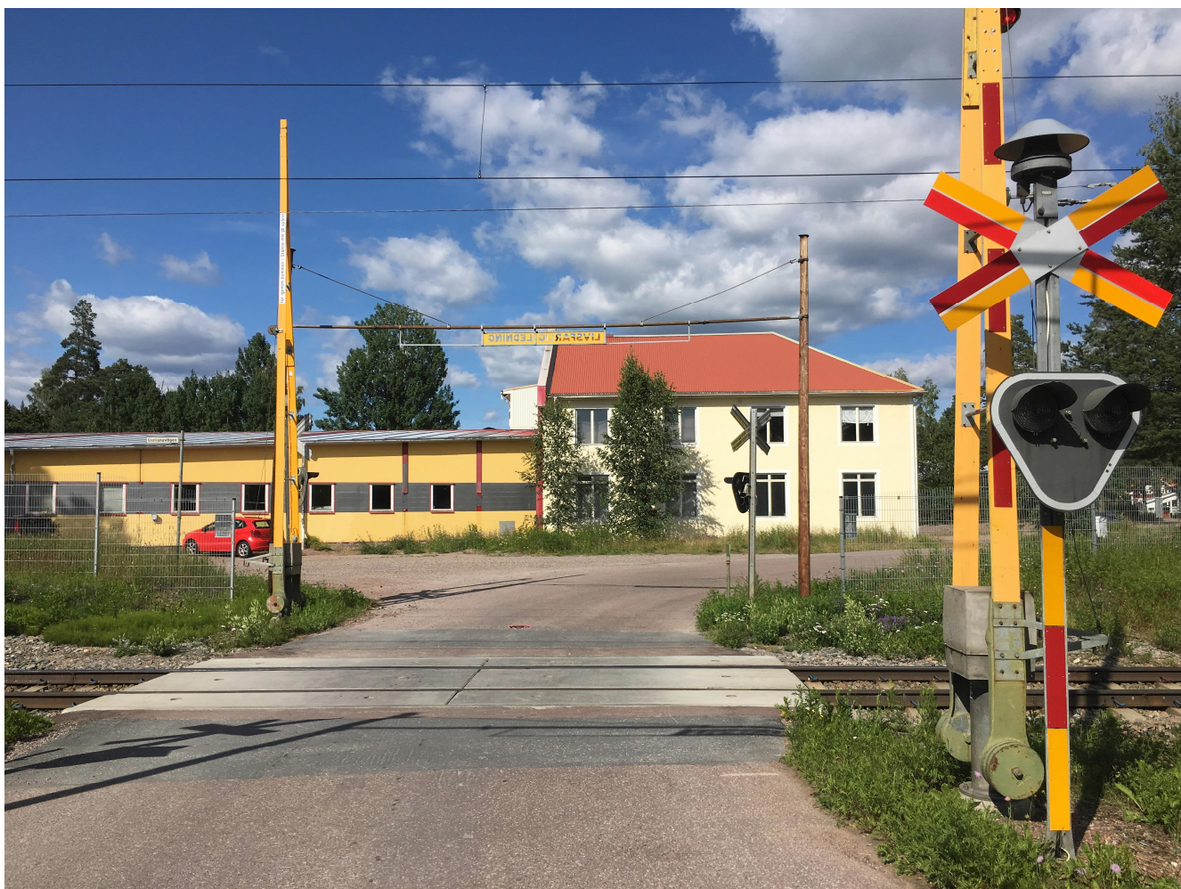
Befintlig plankorsning med järnvägen utmed Morbyvägen i Mora by. Plankorsningen kommer att ersättas med en planskild gång- och cykeltunnel
