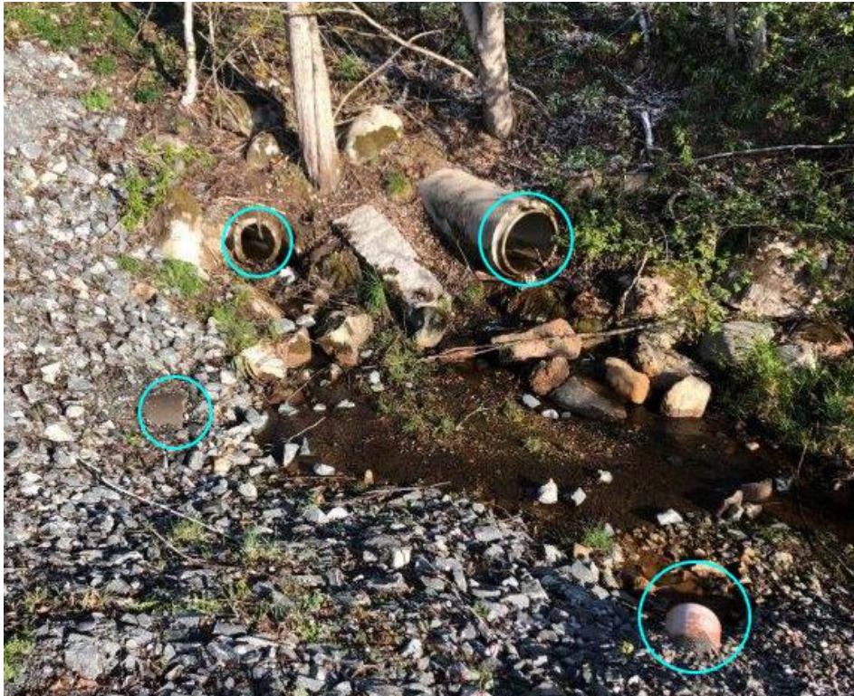
Figur 9. Utloppsledningar på nedströmssidan banvallen där det antas att dagvatten från utredningsområdet kommer behöva ledas. Fotot tillhör Trafikverket.
