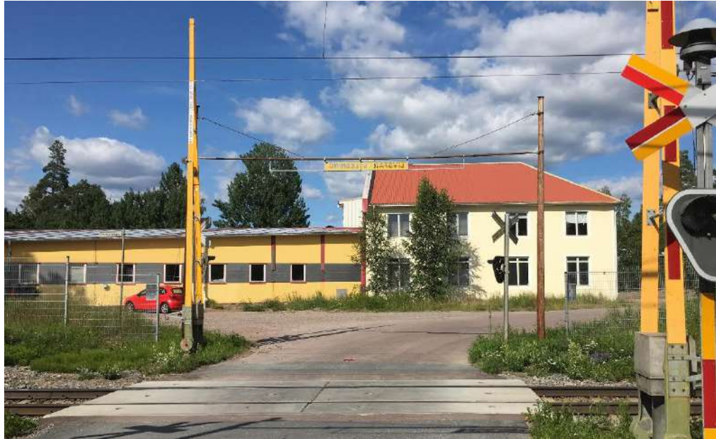
Industribyggnaden vid järnvägsövergången
