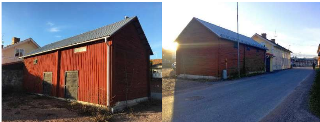
Figur 11 Ekonomibyggnad på Hyddan 8, fasad in mot tomten respektive mot Kungsvägen
