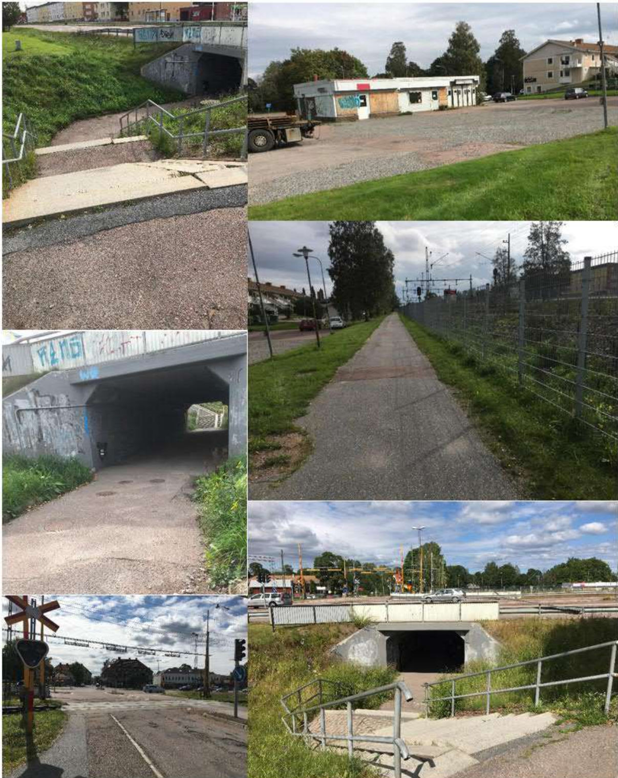
Figur 12. Foton över befintlig bebyggelse i delområde A. Trappor till gångtunneln på norra sidan av väg 70 (överst t.v.), gångtunneln under väg 70 (mitterst t.v.), plankorsning Myntvägen/järnvägen (nederst t.v.), området Tuskaftet med byggnad som tidigare inhyst fordonsverkstad och fordonstvätt (överst t.h, numera riven.), gång- och cykelväg längs norra sidan av järnvägen med alléträd på norra sidan av gång- och cykelvägen (mitterst t.h.), trappor till gångtunneln på södra sidan av väg 70 (nederst t.h.).
