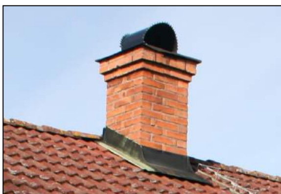
Traditionell skorsten med utkragat krön och huv av svart plåt.
