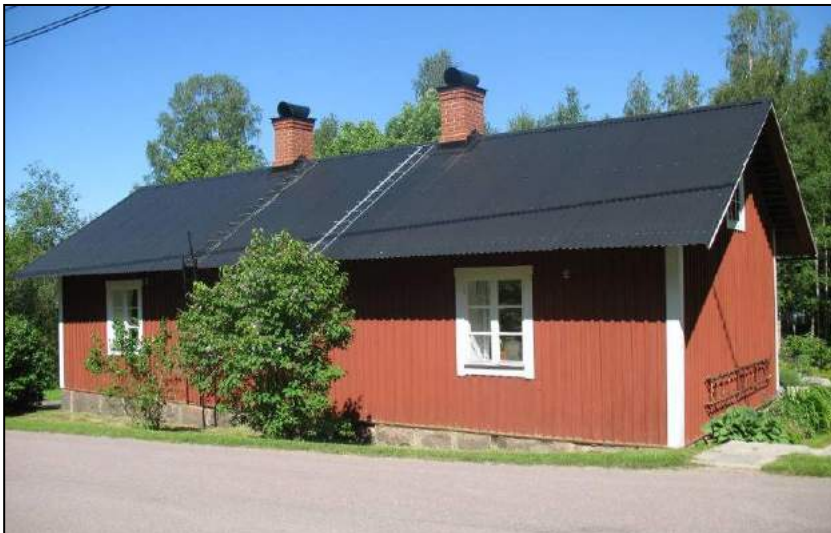
Samma parstuga som på bilden ovan sedd från gatan. Tillbyggnaden syns inte och man kan lätt avläsa byggnadstypen.
