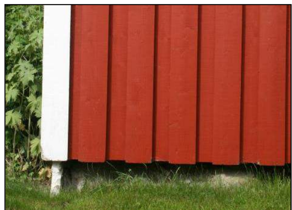
Modern lockpanel utan fotbräda och med jämn bredd på panelbrädorna.
