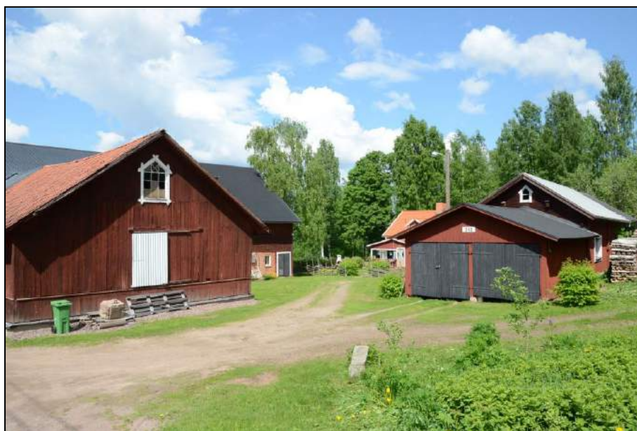
Exempel på ekonomibyggnader från 1900-talet i form av ladugård, loge, garage, uthus m.m. i byn Gruvriset i Bispberg.
