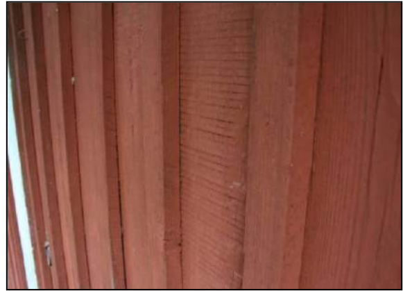
Ramsågad panel där de raka spåren efter sågen fortfarande syns. Före 1900 var panelen i regel ramsågad därefter blev cirkelsågad panel vanlig vilket syns på att spåren blir bågformade.
