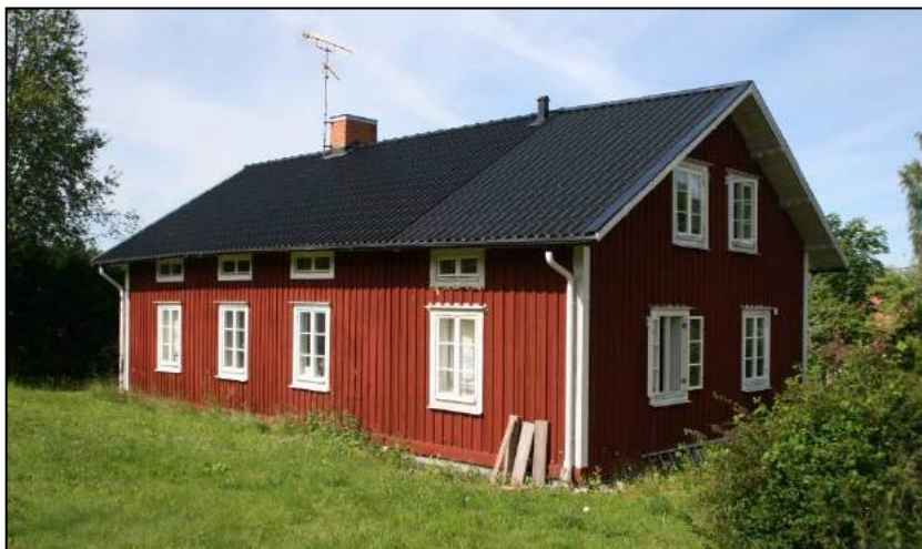
Ett exempel på en tillbyggnad i form av förlängning av befintligt hus. Den högra delen, motsvarande ett fönster på långsidan, är tillbyggd.
