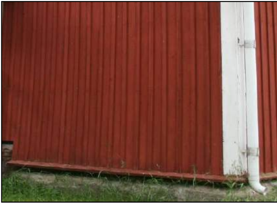
Röd locklistpanel med fotbräda, den vanligaste paneltypen i området.
