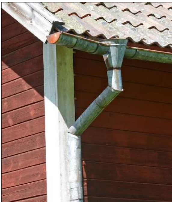
Exempel på ett traditionellt stuprör med skarpa vinklade böjar och en tratt med hål i sidorna för hängrännan.
