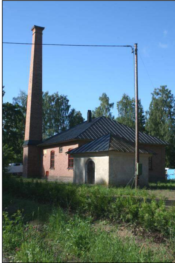
Ångmaskinhuset i bakgrunden och kruthuset i förgrunden.
