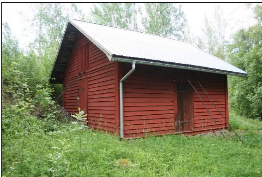
För att kunna göra en tvär sväng på konstgången krävdes ett s.k. vändbrotts hus. I Bisberg finns ett sådant fortfarande bevarat strax intill gruvan.
