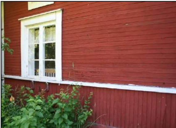
Den spontade panelen förekommer ofta på byggnader uppförda omkring eller efter sekelskiftet 1900. Panelerna utfördes med både stående och liggande brädor och delades ofta in i olika fält med hjälp av vita lister. Spontad panel avslutades alltid med fot- och knutbrädor.
