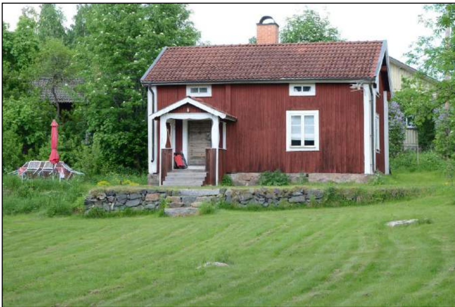
Exempel på terrassering av tomt för att skapa en plan yta runt bostadshuset. Stödmuren är gjord av natursten.
