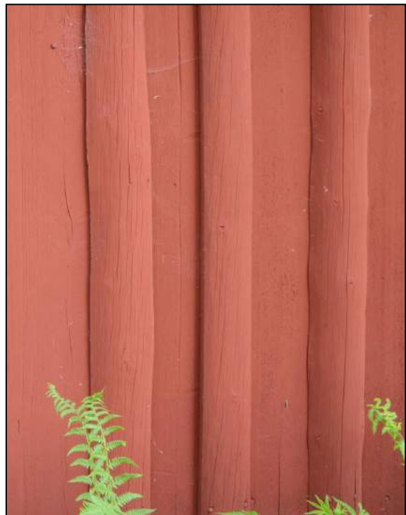
Vankantad panel, vanlig på lador, uthus, bodar och liknande byggnader.
