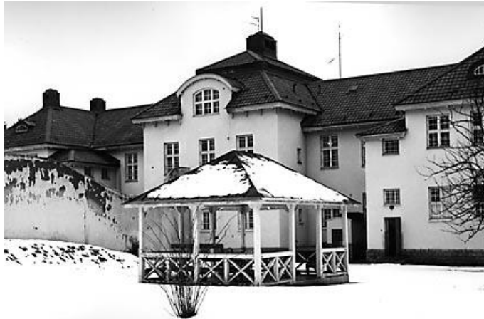
Fasta paviljongen vid Sätters sjukhus 1980-tal. Baksidan av huset med rastgård och soltält. Foto: Mentalvårdsmuseet.
