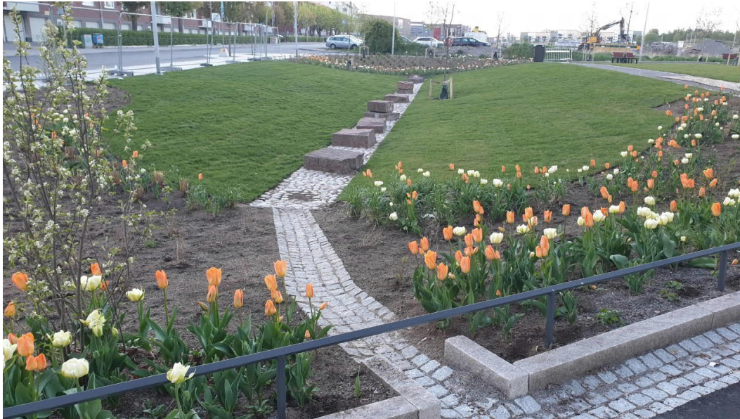
Figur 18. Torrdamm i bostadsområde.
