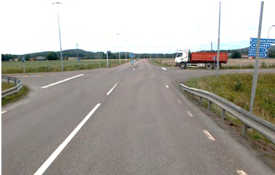
Figur 12; Korsningen vid väg 789/790 sett från söder (bild från Trafikverket)
