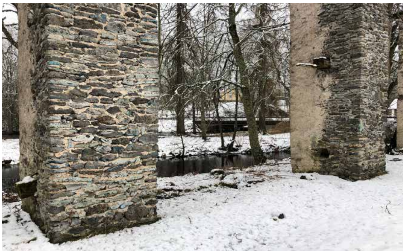
Fig 5. Del av Engelska parken sedd från kolhusruinen. I förgrunden ses två av slaggpelarna och mellan dessa en del av åfåran och holmen med lärkträden. I bakgrunden skimtar den gula herrgårdsflygeln. Foto i april 2019: Helena Kåks.
