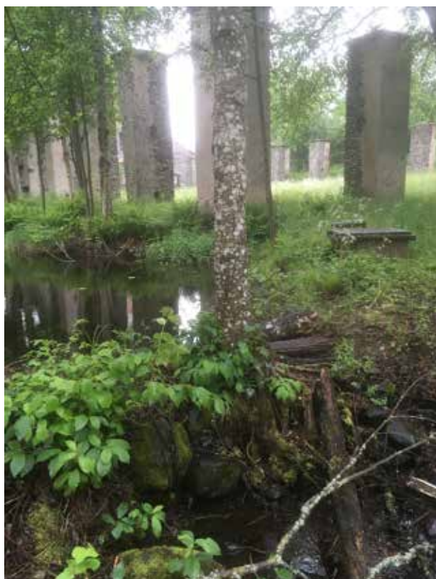
Fig 69. Träd som växer på dammvallarna tas ner eftersom de annars på sikt kan spränga fördämningarna. Stubbarna lämnas orörda. Foto i juni 2019: Helena Kåks.
